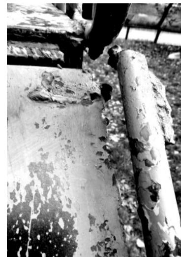
Фрагмент обычной горки. Если при спуске в отверстие рваного металла попадет ладонь или детская ручонка, их просто разорвут.
