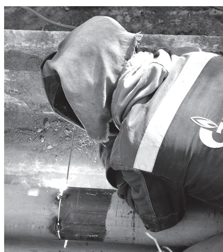
Идетстыковка нового теплопровода на ул. Строительной.
