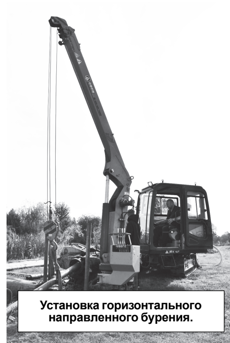
У будущей дренажной камеры трубопровода.
